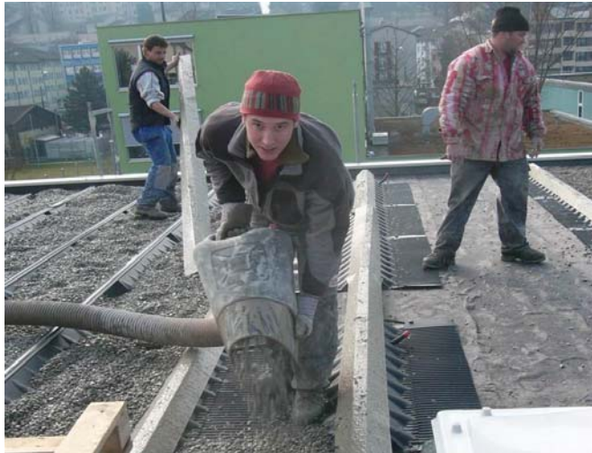
Verteilen des Kiesel oder Gartenplatten auf dem Flachdach
